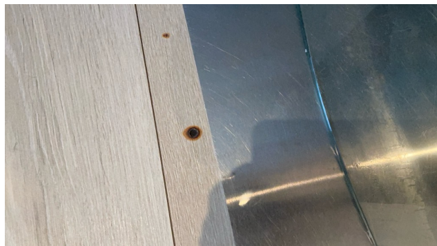
Lite brennmerke i laminat foran ildsted
