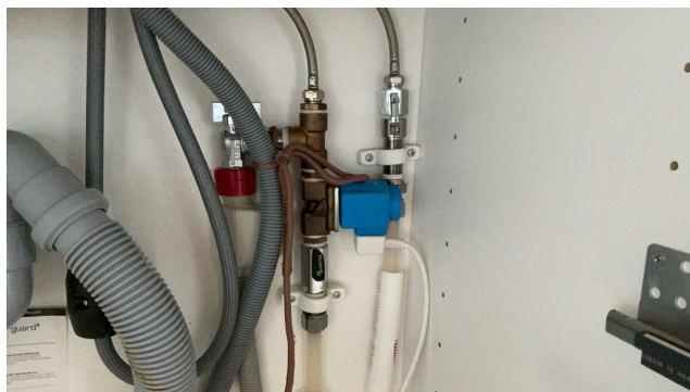
Automatisk lekkasjesikring i kjøkkenskap
