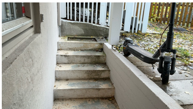
Mangler rekkverk
