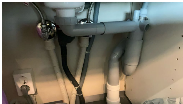
Synlige rør under kjøkkenbenken.
