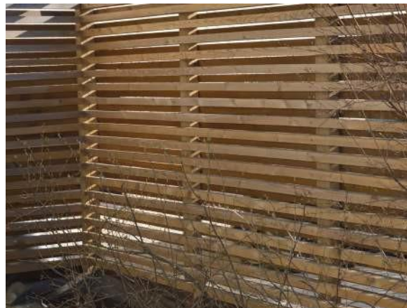
Levegg utført med liggende spiler.
