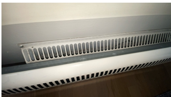
Luftventil bak panelovner.
