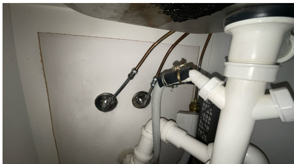
Rør i underskap på kjøkken.
