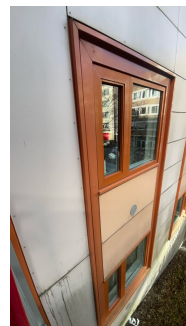
Lufteventil i yttervegg under vindu.
