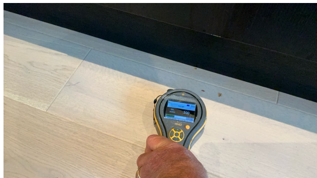
Fuktsøk med Protimeter MMS på gulv foran oppvaskmaskin og kjølfrys. Normale verdier registrert
