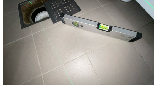
Fallforhold målt i retning sluk.
