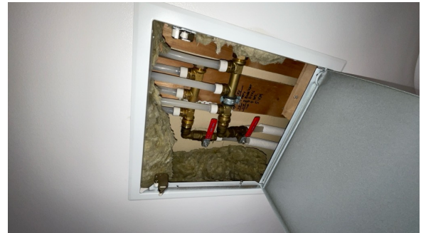
Samlestokk over himling på baderommet.
