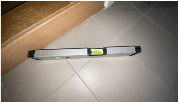
Fallforhold målt i retning sluk.
