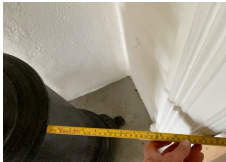
Avstand til brennbart materiale er mindre enn 30cm.
