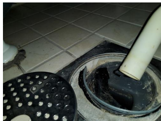
Tettesjiktets tilslutning til sluk - Sluk under badekar bad 1.
