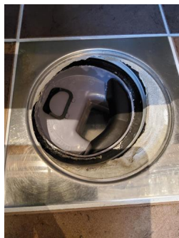
Tettesjiktets tilslutning til sluk - Sluk under servantskap bad 2.
