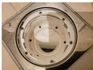
Tettesjiktets tilslutning til sluk - Sluk utenfor dusjsonen bad 3.
