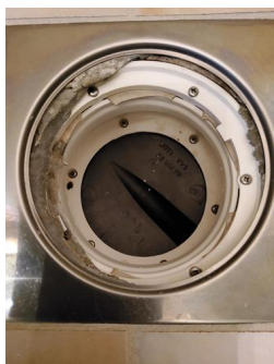
Tettesjiktets tilslutning til sluk - Sluk i dusjsonen bad 3.
