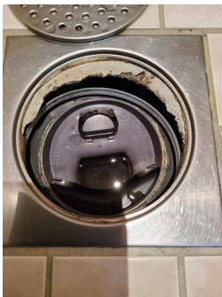
Tettesjiktets tilslutning til sluk - Sluk i dusjsjonen bad 1.
