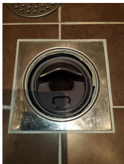
Tettesjiktets tilslutning til sluk - Sluk i dusjsonen bad 2.
