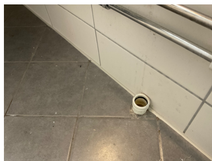
Avløpet fra den gamle servanten bør plugges. 32mm PP rør.
