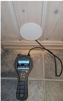
Kontroll i lukkede konstruksjoner - Fuktmåling
