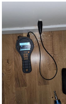
Utført kontroll i tilleggende konstruksjon - Fuktmåling
