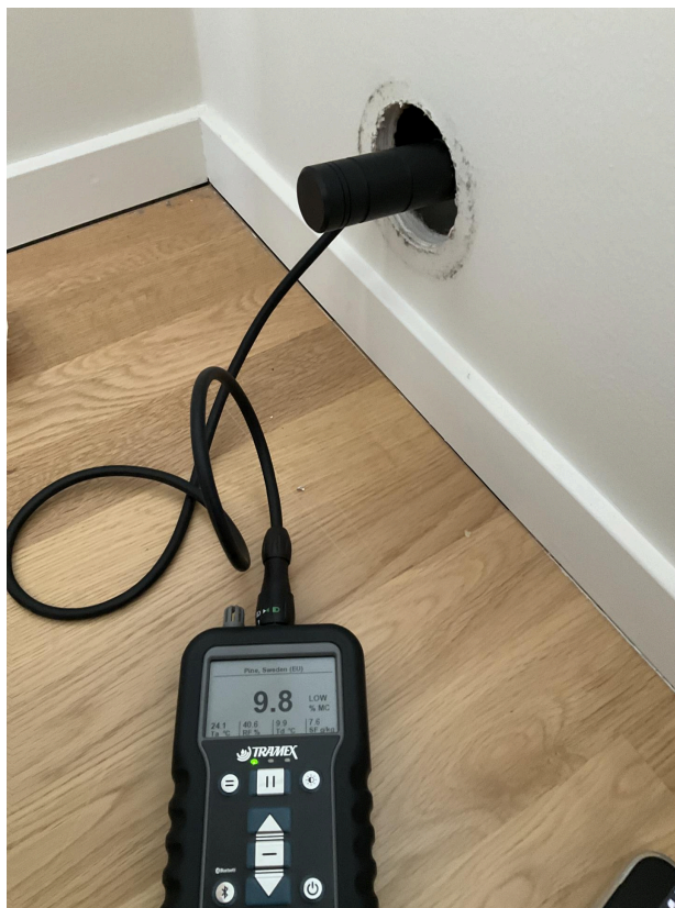
Ved hulltaking i tilleggende konstruksjon mot dusjhjørne ble det ikke påvist unormale fuktverdier.
