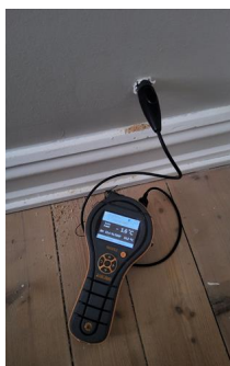
Utført kontroll i tilliggende konstruksjon - Fuktmåling
