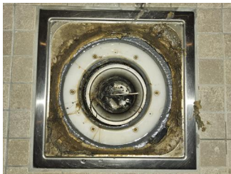
Tettesjiktets tilslutning til sluk - Sluk bad
