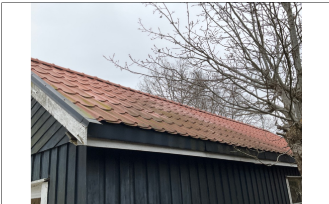
Gammel platetaktekking .
