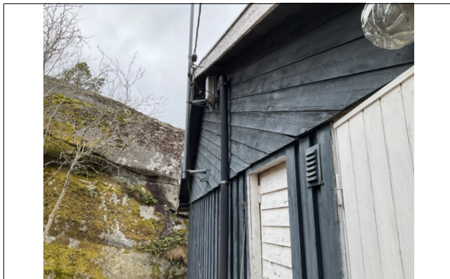
Gammel slitt kledning og dører.
