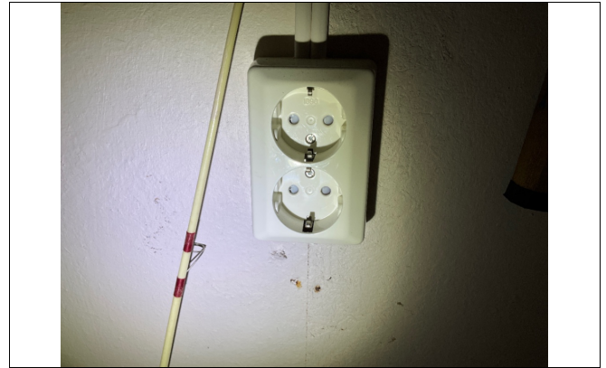
Kontroll av stikkontakt til VVB
