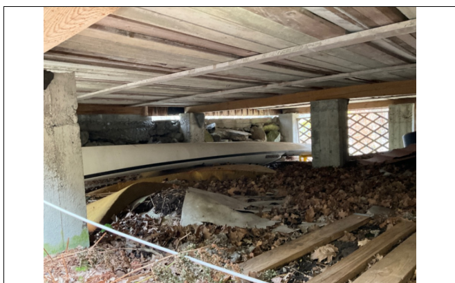
Kontroll av krypprom under hytta.
