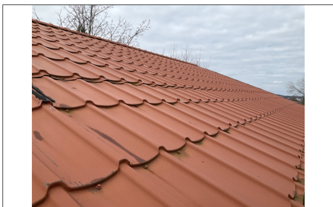
Gammel platetaktekking
