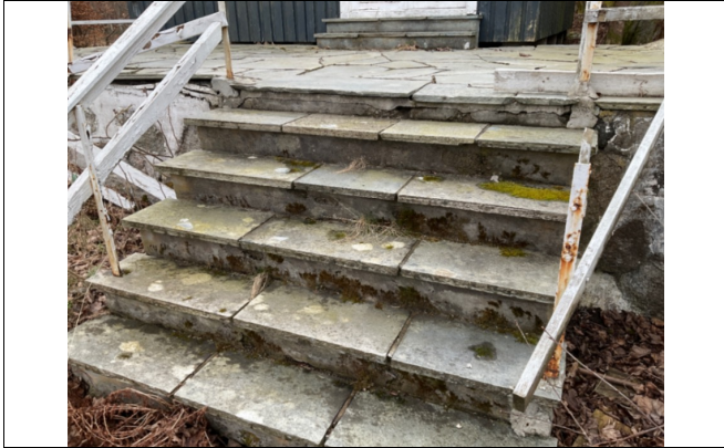
Defekt rekkverk.
