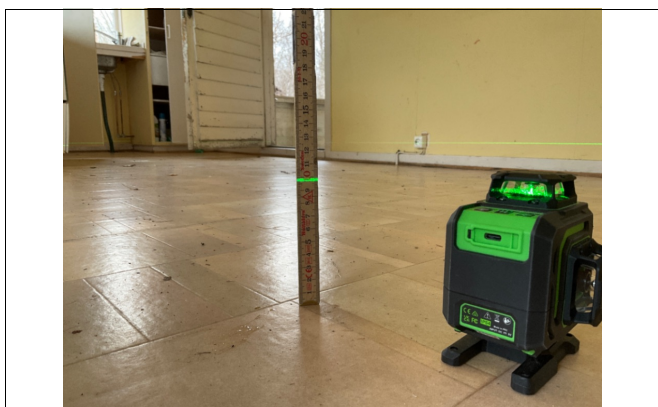
Nivellering av gulv og kontroll av skjevhet.
