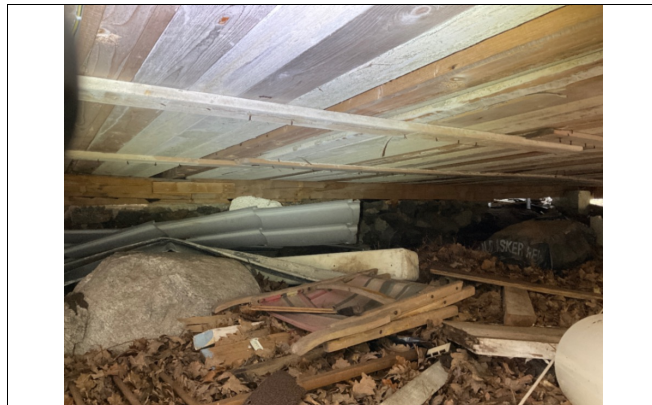
Kontroll av krypprom under hytta.
