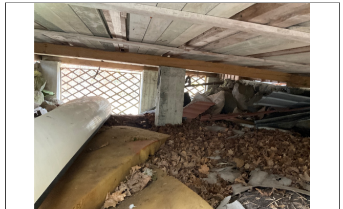
Kontroll av kryprom under hytta.
