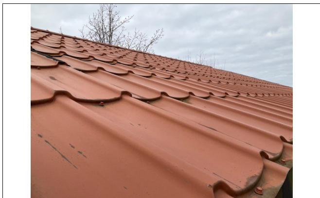
Gammel platetaktekking
