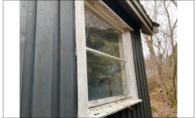
Gamle vinduer og kledning
