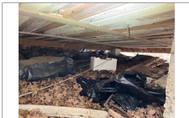
Kontroll av krypprom under hytta.
