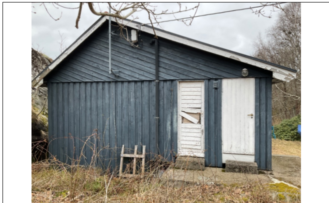
Fasade. Slitt kledning
