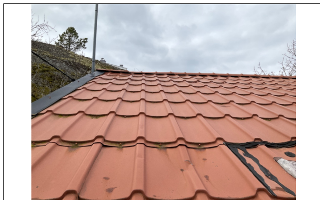
Gammel platetaktekking
