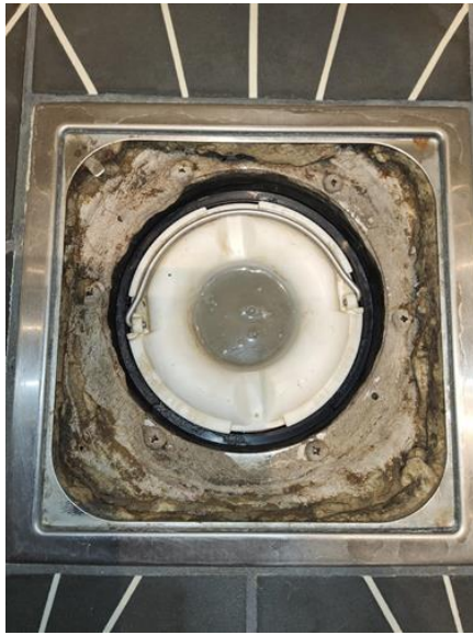
Våtrom - [Sluk bad]
