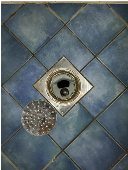
Membran, tettesjikt og overgang til sluk. - [Sluk Baderom 8 A, i dusjnisje.]
