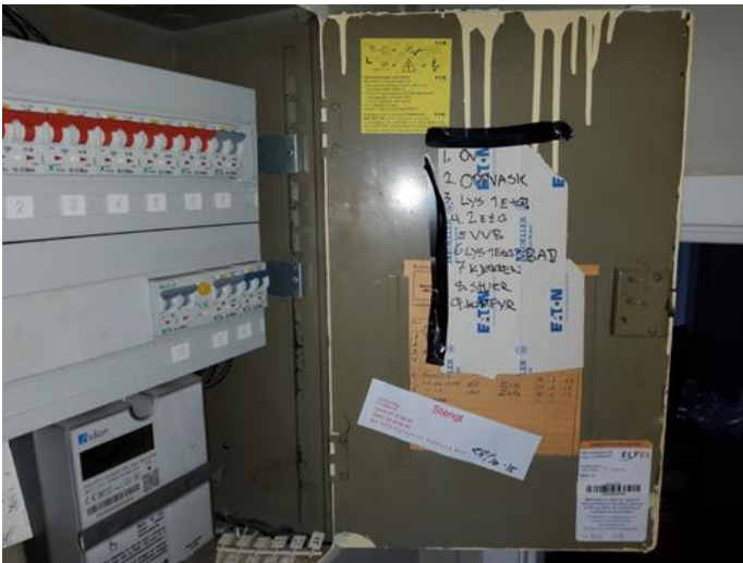
Elektrisk anlegg - [Kursfortegnelse 8 B.]
