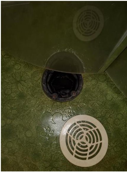
Membran, tettesjikt og overgang til sluk. - [Sluk Baderom 8 B.]
