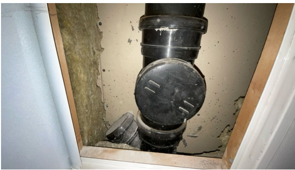
Avløpsrør fra byggeår med stakeluke
