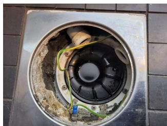
Tettesjiktets tilslutning til sluk - Sluk bad
