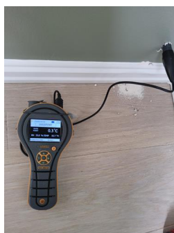
Utført kontroll i tiliggende konstruksjon - Relativ luftfuktighet
