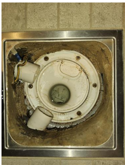
Tettesjiktets tilslutning til sluk - Sluk bad
