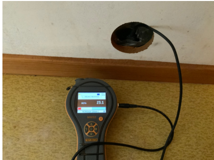
Hulltaking i yttervegg mot terreng
