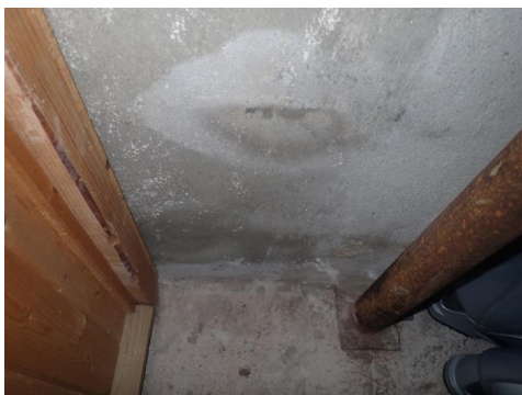
Saltutslag på åpen mur vegg og gulv
