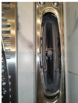
Tettesjiktets tilslutning til sluk - Sluk
