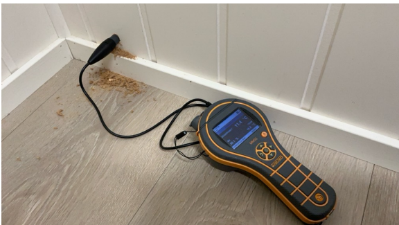
Måling av relativ luftfuktighet i lukket veggkonstruksjon. Måling foretatt i gang i underetasje.
