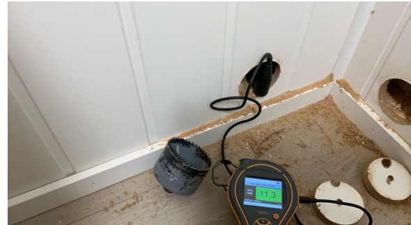
Måling av trefukt i lukket trekonstruksjon mot våtsone fra gang i underetasje.
