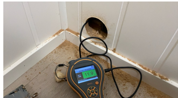
Måling av trefukt i lukket trekonstruksjon. Målingen er foretatt i gang i underetasje.
