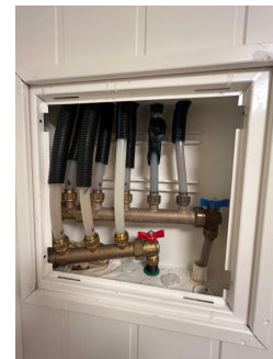
Fordelerskap uten sprutsikkert deksel og kursoversikt.
