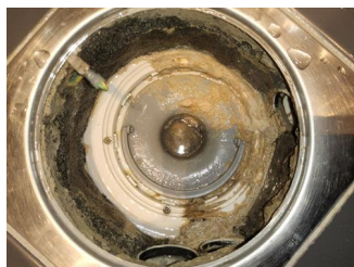
Tettesjiktets tilslutning til sluk - Hovedsluk.
