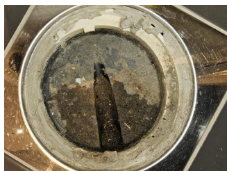
Tettesjiktets tilslutning til sluk - Hjelpesluk.
