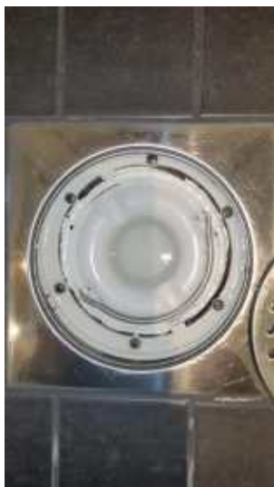
Våtrom - [Sluk bad]
