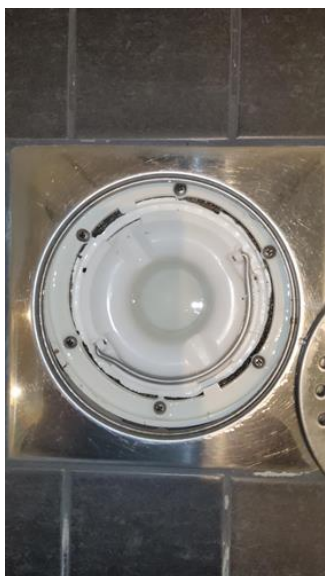
Våtrom - [Sluk bad]
