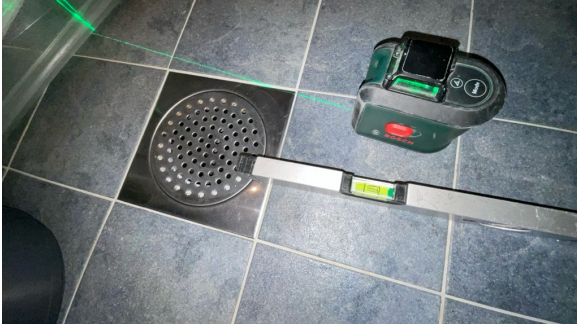
Fallforhold målt i retning sluk.
