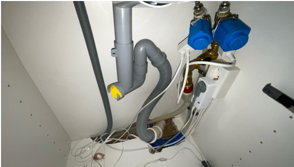
Rør på kjøkken.
