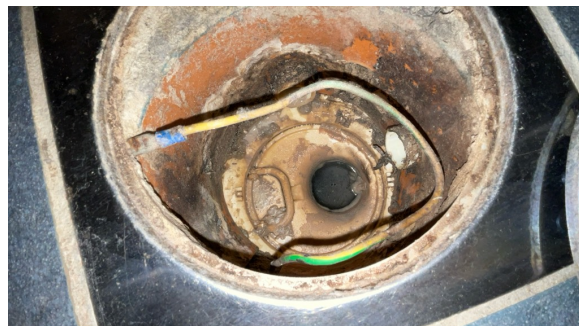
Hovedsluk under servantskap.
