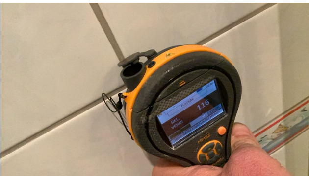
Fuktsøk vegg dusjsone med Protimeter MMS
