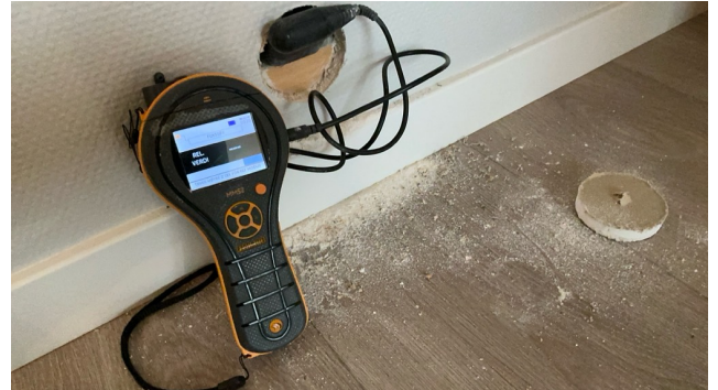
Fuktkontroll med Protimeter MMS i vegg mot baderom.
