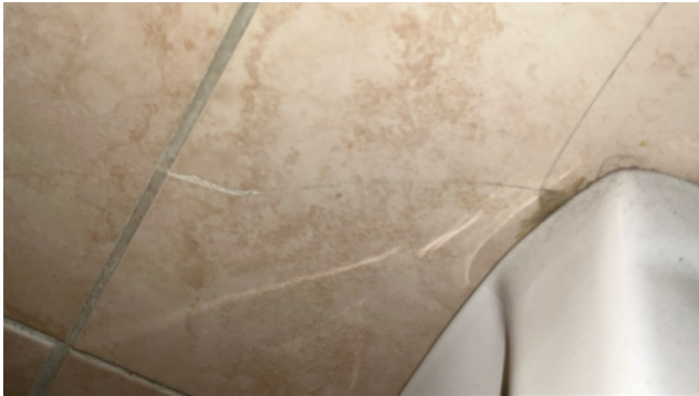
Sprekk flis på vegg ved toalett. Det kan ikke utelukkes flere sprekker/riss.
