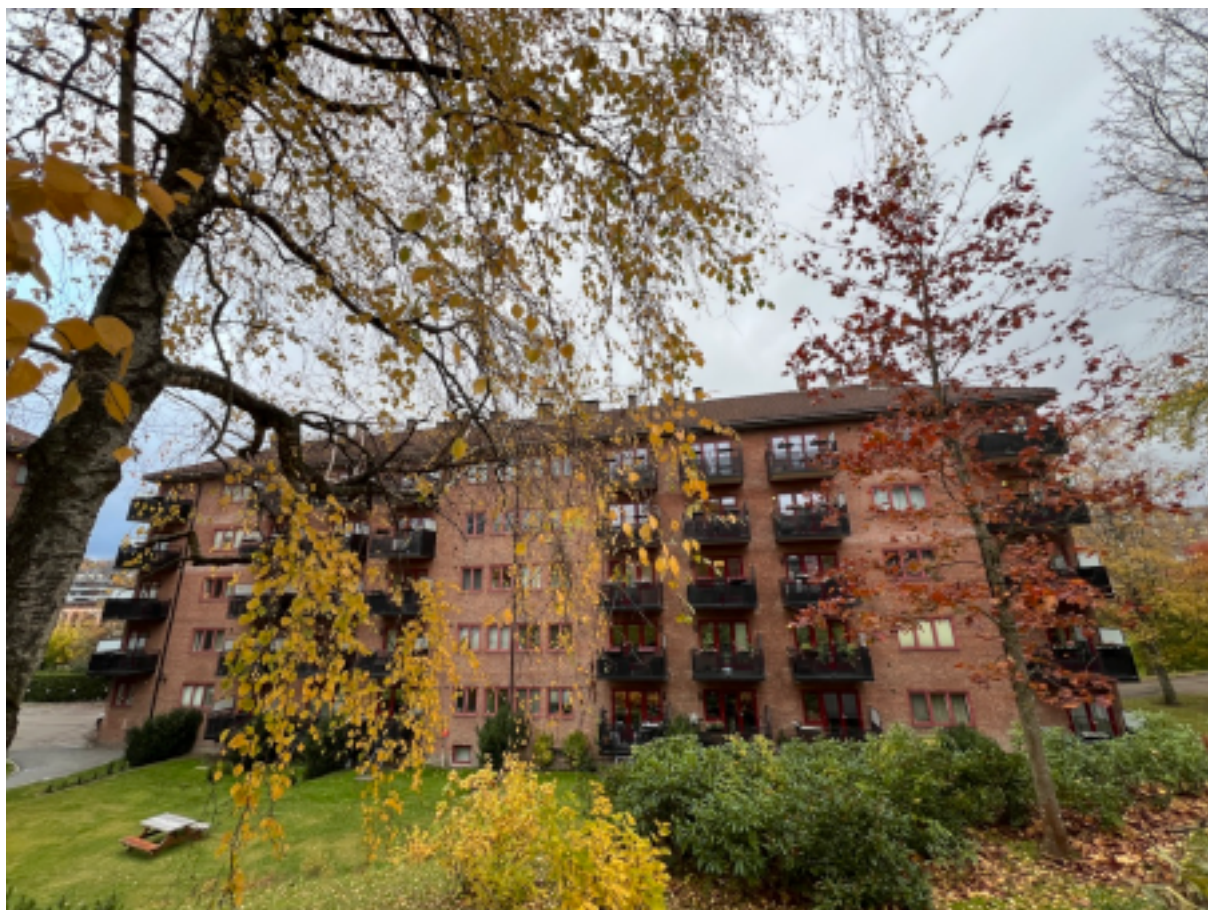
Utsyn fra Maridalsveien gangvei østover mot Maridalsveien 233 – 24. oktober 2023
