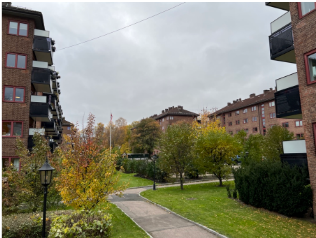
Utsyn mot syd mellom Maridalsveien 231, 233, 235 og 237 – 24. oktober 2023
