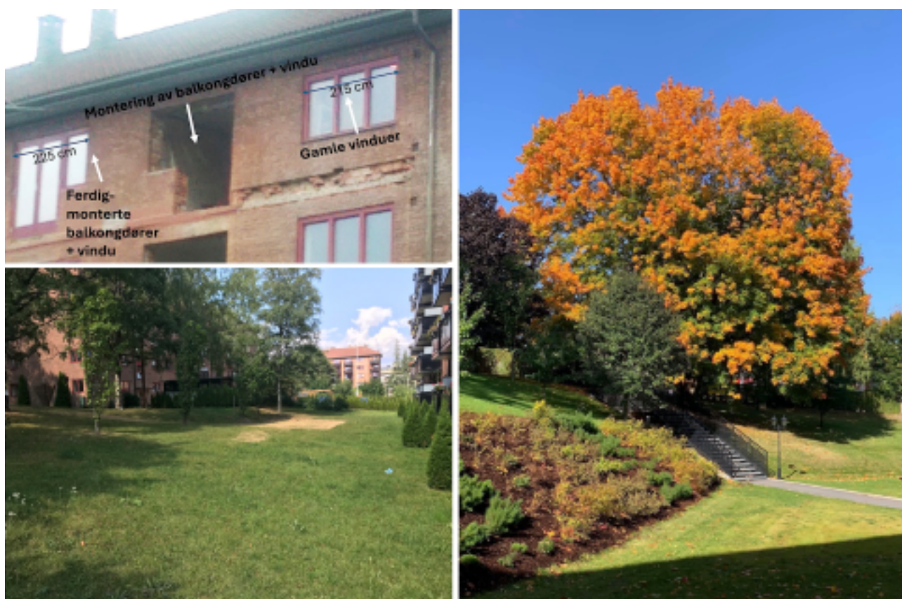
Montering av større vindusparti med dobbelte dører i stuene 2014-2015 (balkongprosjektet), trær som er plantet for å hindre vanninnsigning og verneverdig trær mellom Maridalsveien 233 og 235.
