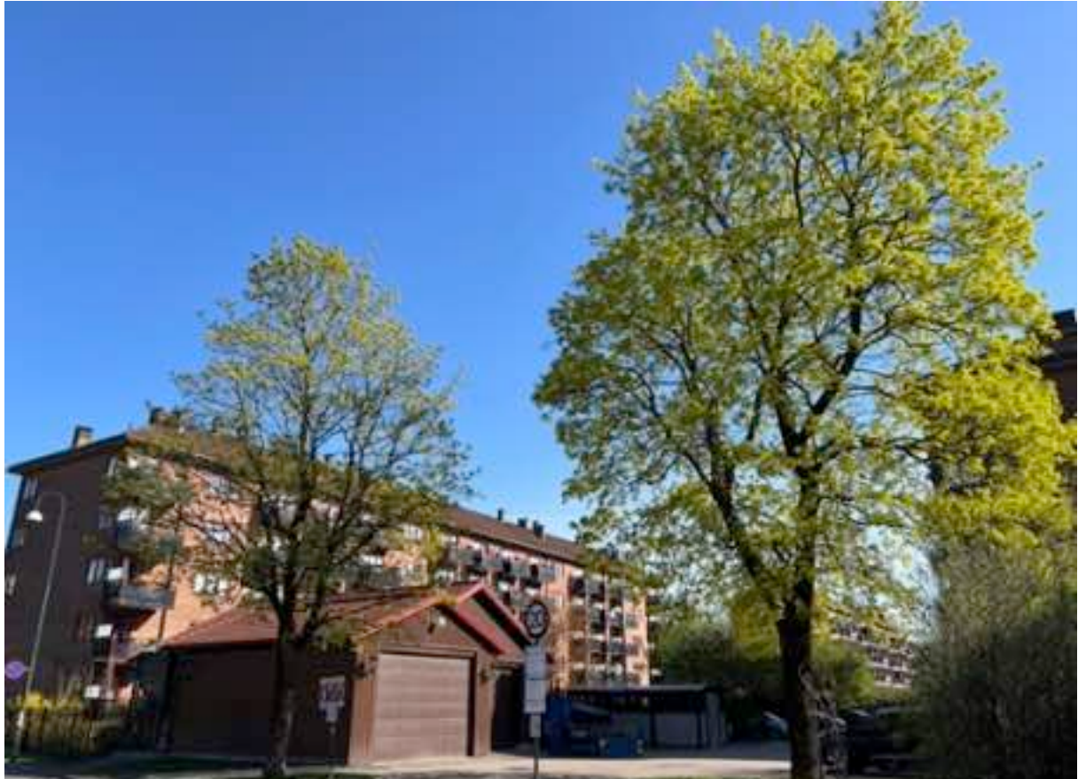
Garasjen foran Maridalsveien 227 – 4. mai 2024
