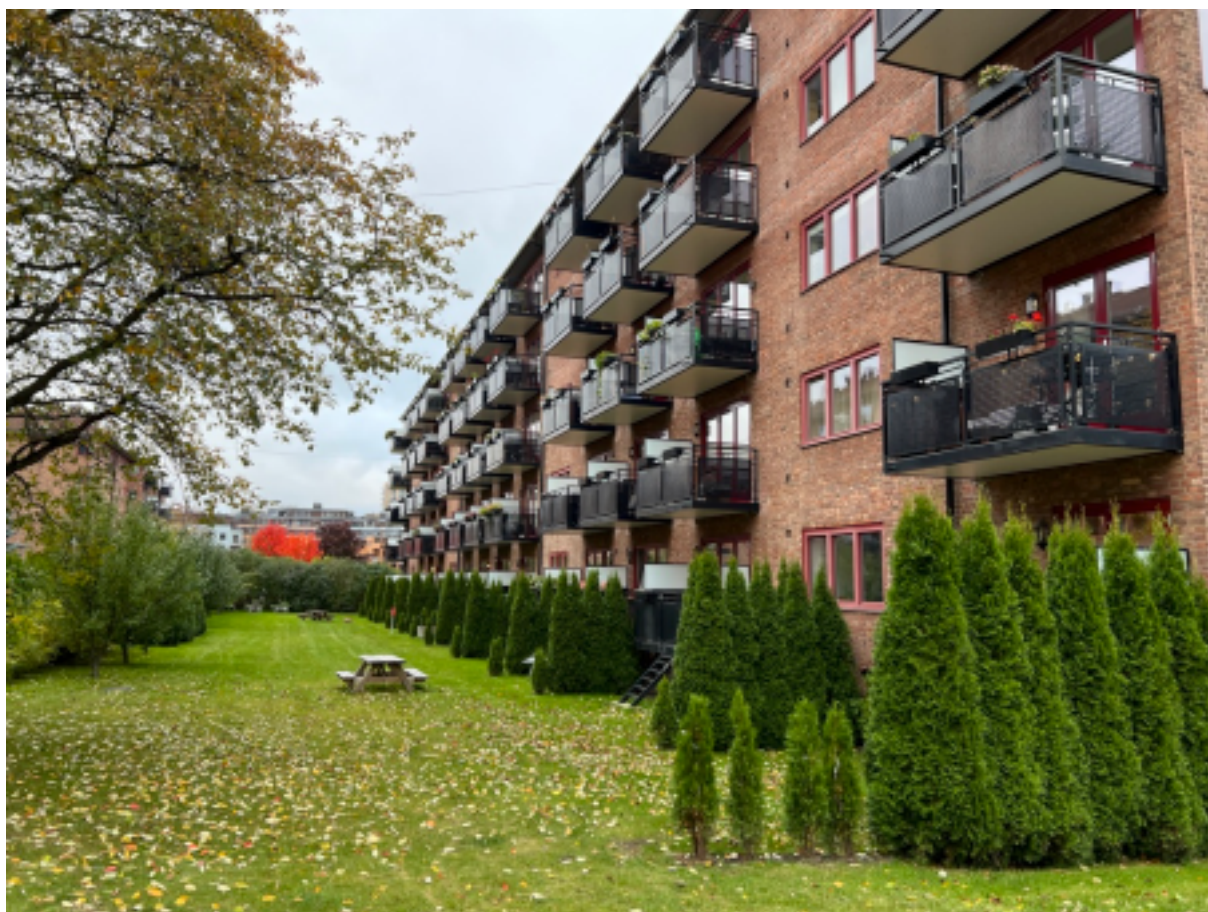
Utsyn mot nord bak Maridalsveien 231 og 225 – 24. oktober 2023
