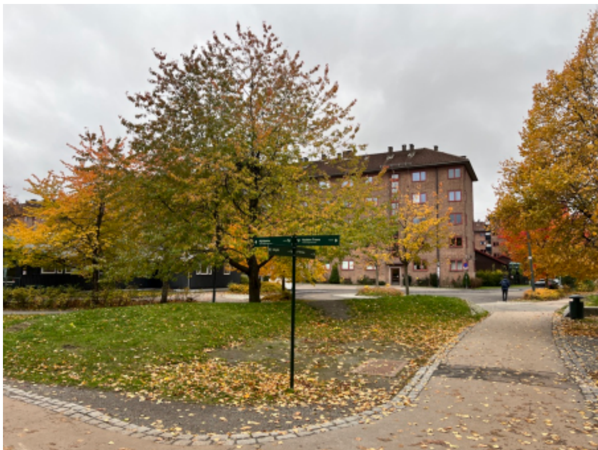
Borettslaget sett fra Akerselva retning vest – 24. oktober 2023
