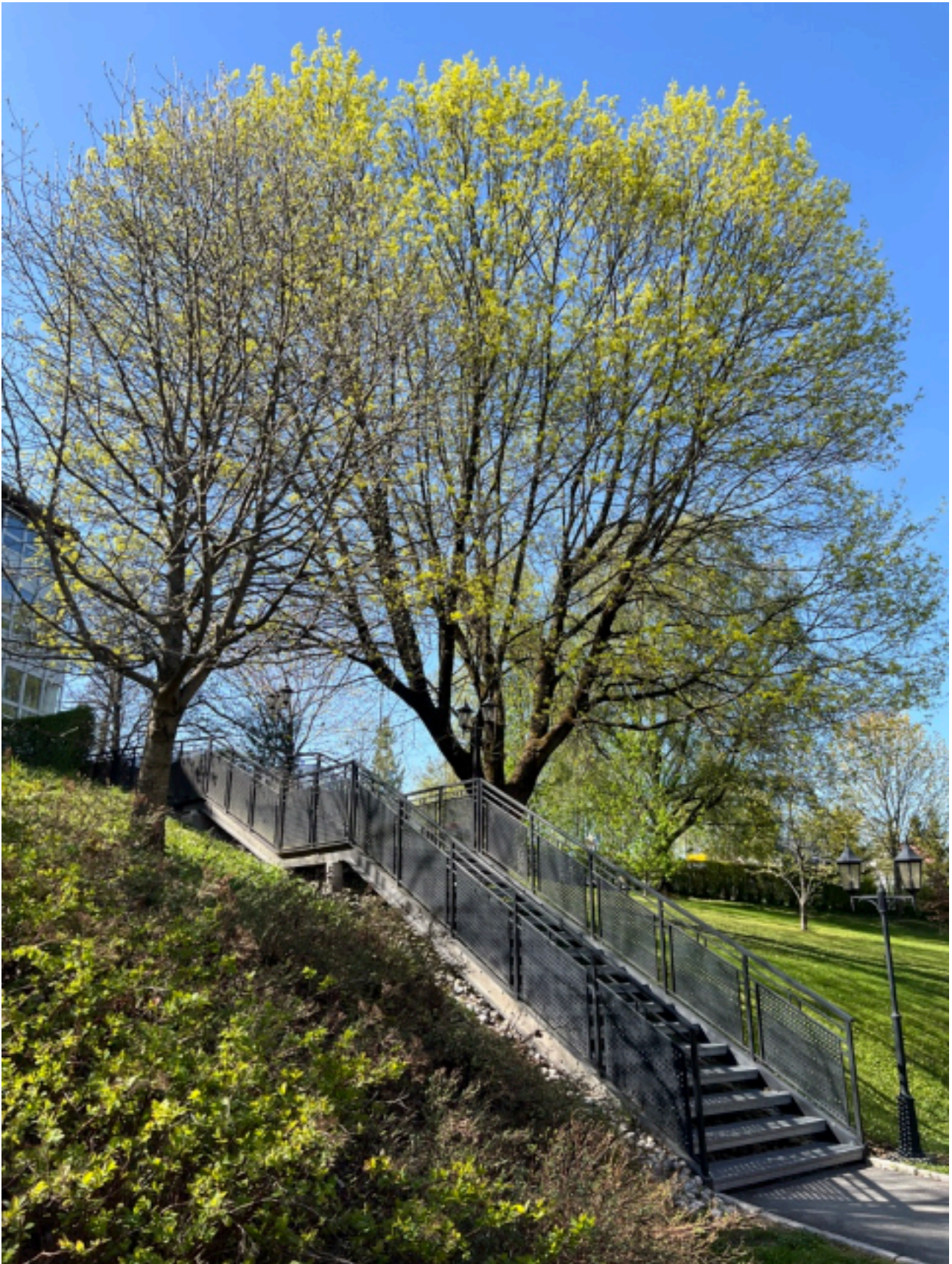
Trappen bak Maridalsveien 235 og 233 mot Voldsløkka – 2. mai 2024
