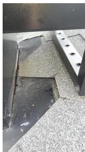
Takgjennomføringer - [Fotbeslag pipe]
