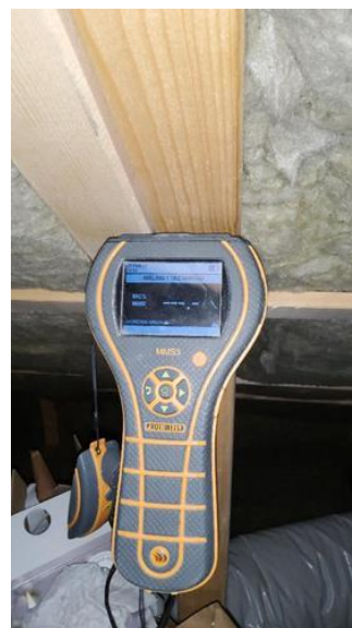
Annet - [Fuktmåling uinnredet loft]
