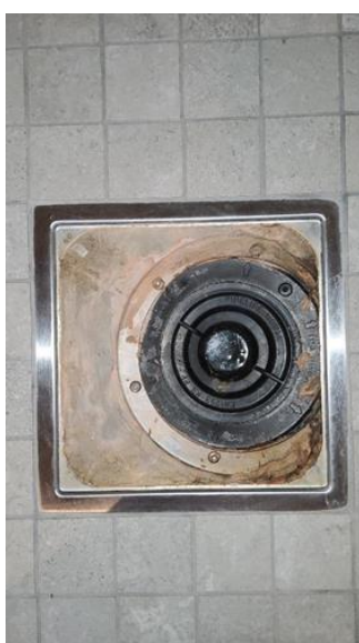
Membran, tettesjikt og overgang til sluk. - [Sluk bad]
