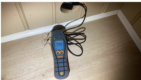
Ved fuktmåling registrerte jeg tørre verdier.
