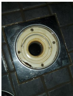
Tettesjiktets tilslutning til sluk - Sluk
