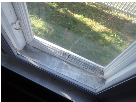
Værslitte og sprukne vinduer fra byggeår. Glass er sprukket
