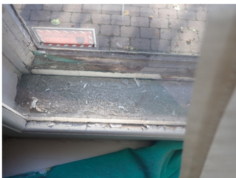
Værslitte og sprukne vinduer fra byggeår. Glass er sprukket
