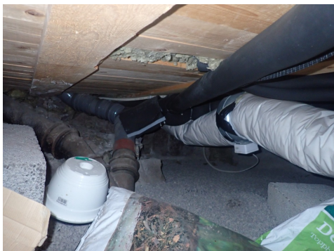
Bilde inn via luke i grunnmur.
