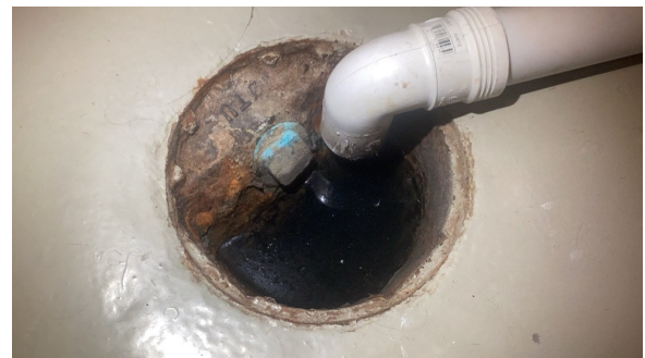
Kontroll av sluk.
