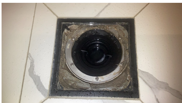
Kontroll av sluk.
