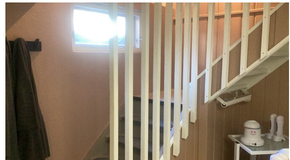
Trapp mellom 1 etg. og loftsetasje.
