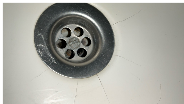
Synlige riss/sprekker
