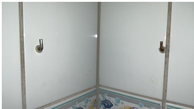
Skruehull i vegg dusjsone
