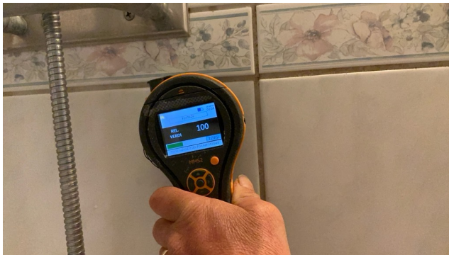
Fuktsøk vegg med Protimeter MMS
