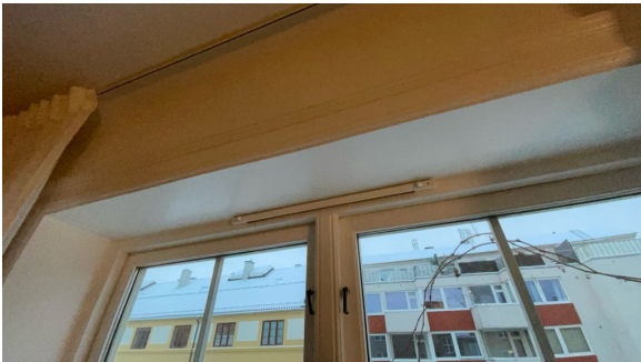
Luftespalte type over tilsvarende vinduer.
