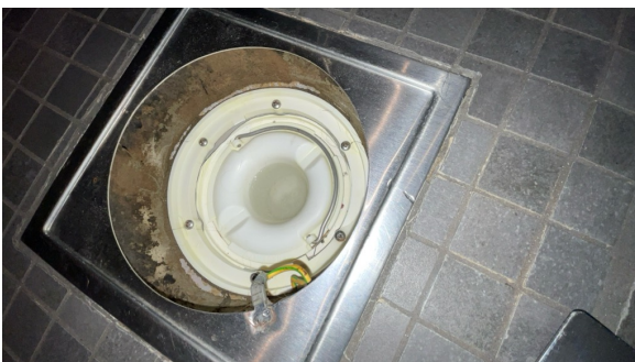
Sluk med synlig dukmembran under klemring.
