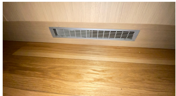
Utkast i sokkel fra kullfilterviften.
