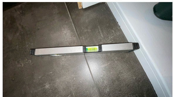
Fallforhold målt i retning sluk.
