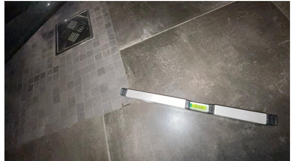
Fallforhold målt i retning sluk.
