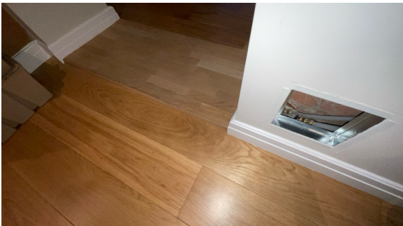
Vannrør er lagt under gulv.
