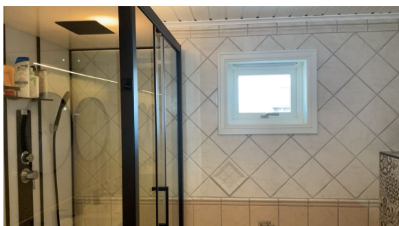
Vindu av tre i våt sone.
