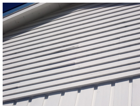
Kledning på gavl sør er noe værslitt
