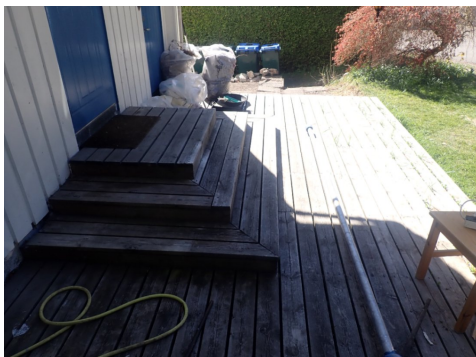
Platting og trapp foran inngangsparti.
