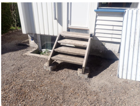
Trapp i tre fra stue til terreng
