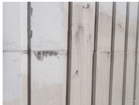
Kledning på gavl sør er noe værslitt
