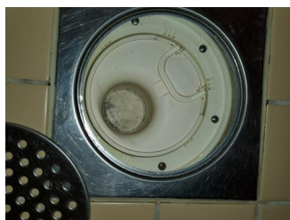
Tettesjiktets tilslutning til sluk - Sluk
