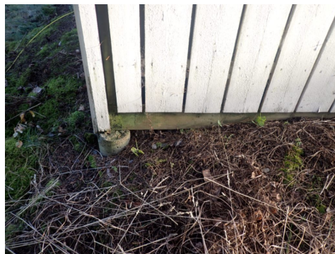
Fundament til terrasse.
