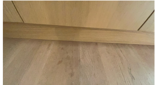
Lufterist i sokkel her blir montert etter takstbefaring.
