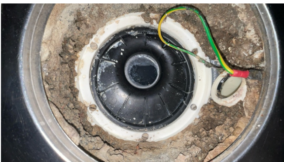
Sluk med synlig dukmembran og klemring.
