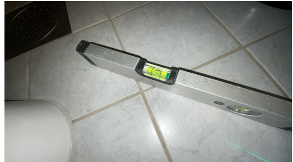
Fallforhold målt i retning sluk.
