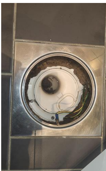
Membran, tettesjikt og overgang til sluk. - [Sluk i dusjsone bad]
