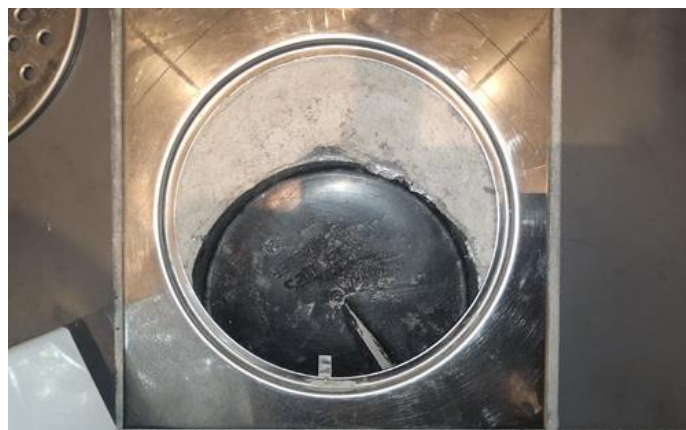
Membran, tettesjikt og overgang til sluk. - [Sluk utenfor dusjsonen bad]
