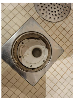
Tettesjiktets tilslutning til sluk - Sluk
