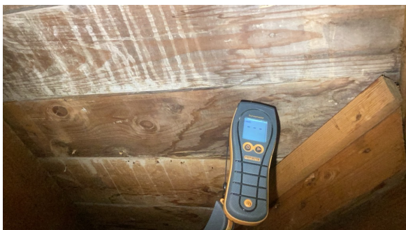
Ved enkle fuktmålinger registrerte jeg tørre verdier.
