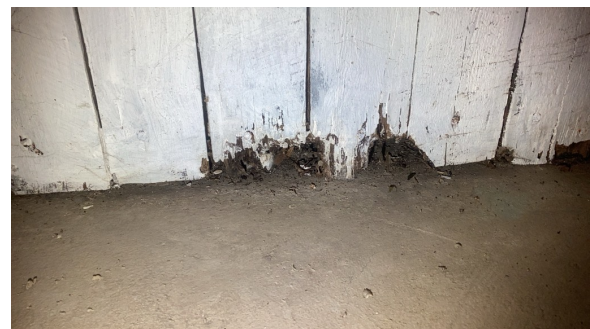
Råteskadet treverk.
