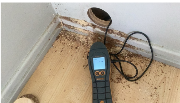
Ved fuktmåling ble det registrert tørre verdier (under 12%).
