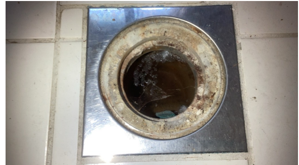
Kontroll av sluk.
