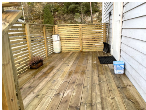
Ny terrasse foran inngangsparti mot nord.
