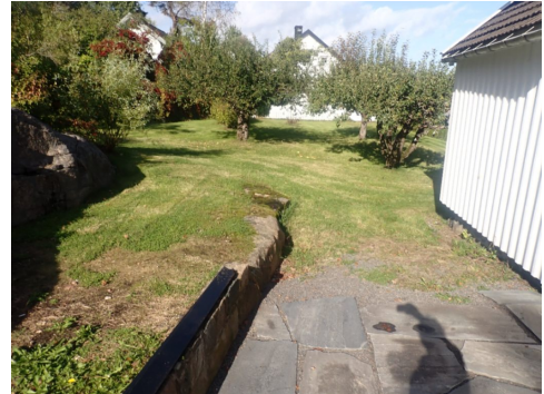
Mindre forstøtningsmur ved trapp.
