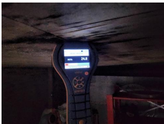
Stikktaking i treverk, fukt og fuktmålinger - Fuktmåling
