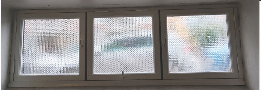
Eksempel på vindu i vaskekjeller før og etter rehabilitering
